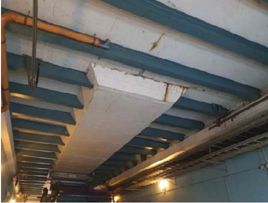
5,6 pav. bunkerio dugno plokštės pažaidos
