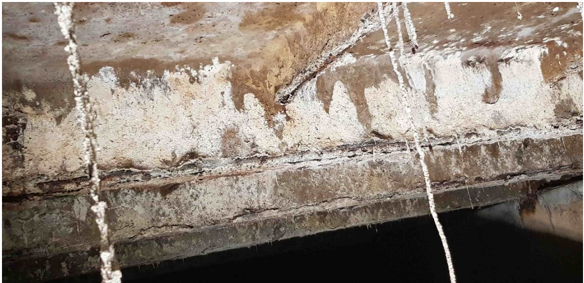
21 pav. Korozijos pažeista G/B perdanga
