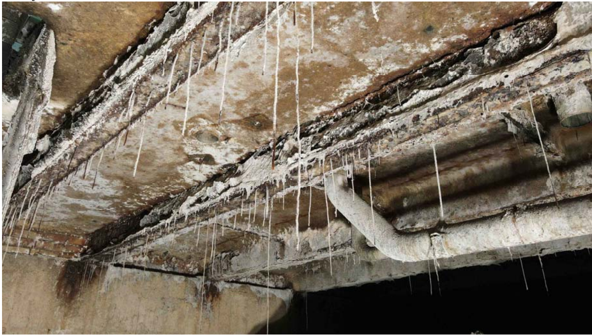
18 pav. Bunkerio perdangos metalinių sijų pažeidos. Vaizdas iš apačios(bunkerio vidaus).
