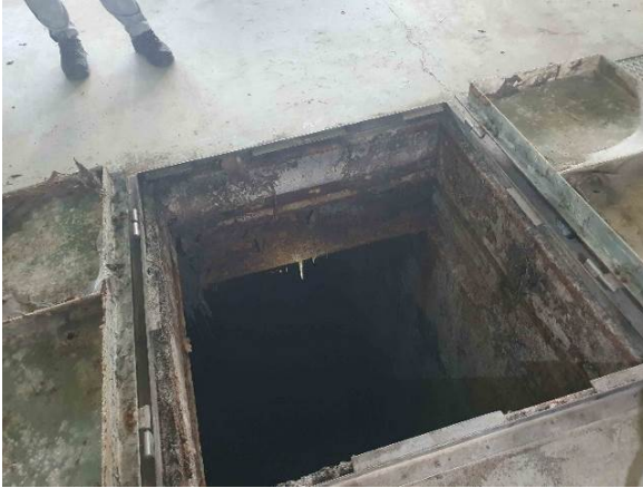
11,12 pav. Metalinių sijų korozija ties anga
