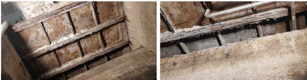
22,23 pav. Korozijos pažeista G/B perdanga
